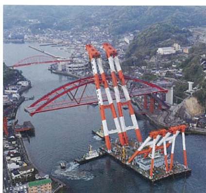
架橋設置工事
