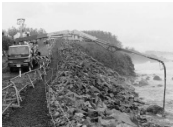
コンクリート・ポンプ車
