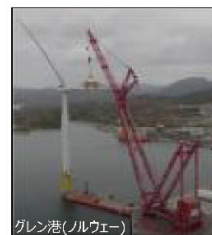
グレン港（ノルウェー） （出所）equinox社 youtube 洋上風力発電設備向けリングクレーン
