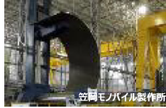
岡モノパイル製作所
