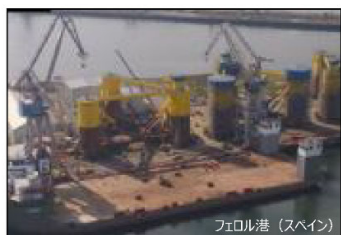
フェロル港（スペイン） （出所）Flotation Energy社資料 ヤードにおける浮体基礎製作の様子
