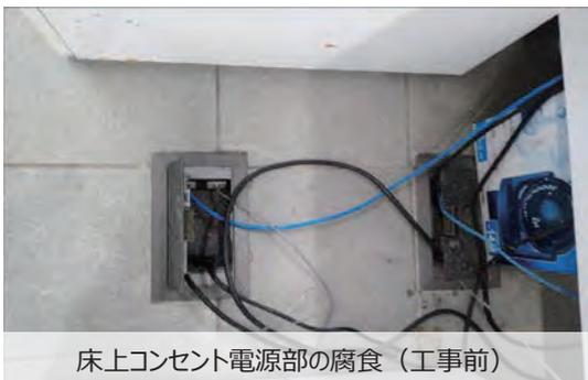
床上コンセント電源部の腐食（工事前）
