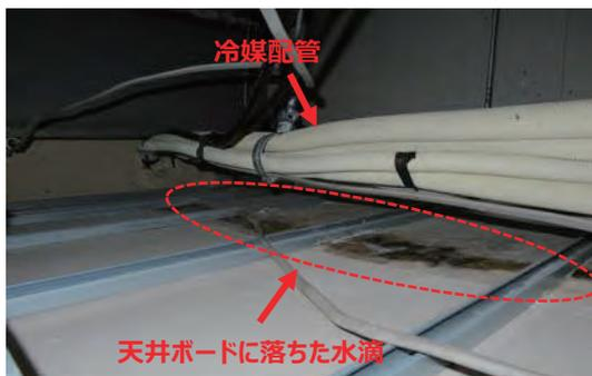
天井裏の冷媒配管が結露し、水滴が落ちてカビが発生
