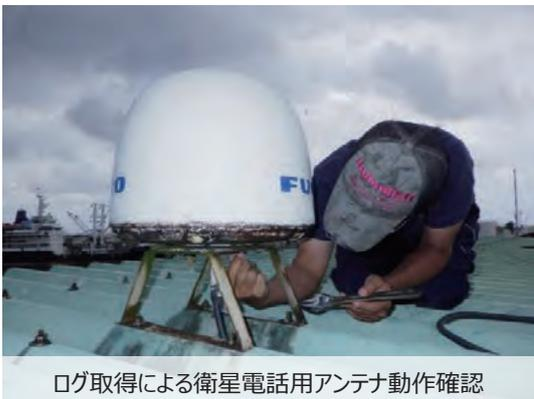
ログ取得による衛星電話用アンテナ動作確認
