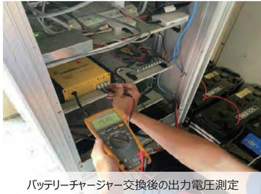
バッテリーチャージャー交換後の出力電圧測定
