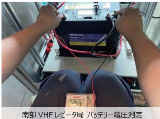
南部 VHF レピータ局 バッテリー電圧測定
