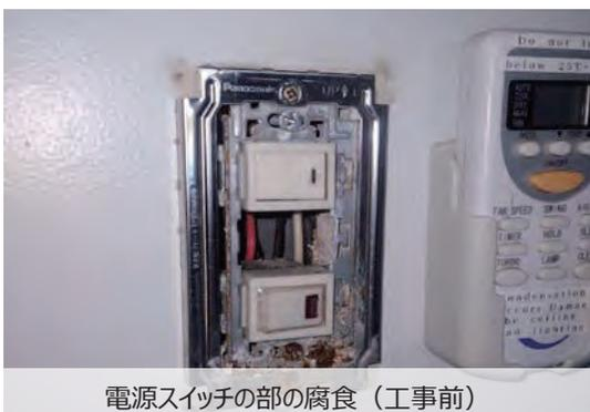
電源スイッチの部の腐食（工事前）
