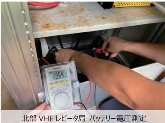
北部 VHF レピータ局 バッテリー電圧測定
