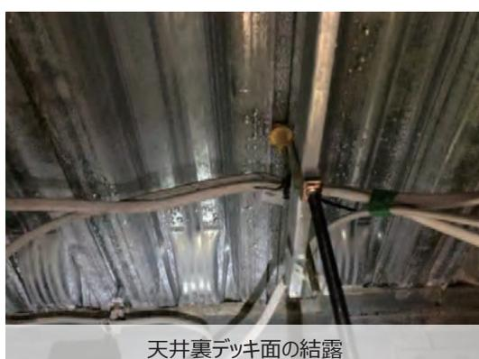
計測の結果、昼間の天井裏の温度は概ね 25℃以上、湿度は 80%以上、デッキ面は概ね 23℃以下であった。天井裏の温湿度を基に算出した露点温度（結露が発生する温度）は最高で 25.3℃であるが、デッキ面の温度がこの露点温度を下回る箇所が多数存在し、結露が発生しやすい環境であることが判明した。また、エアコンの冷媒配管の結露が多数の箇所を確認されたが、岩田地崎建設によると冷媒配管の断熱効果が不足または低下していることが原因と考えられるとのことであった。その他、結露が原因と考えられる照明不良、照明スイッチ発錆、床上コンセントの不通も確認された。
