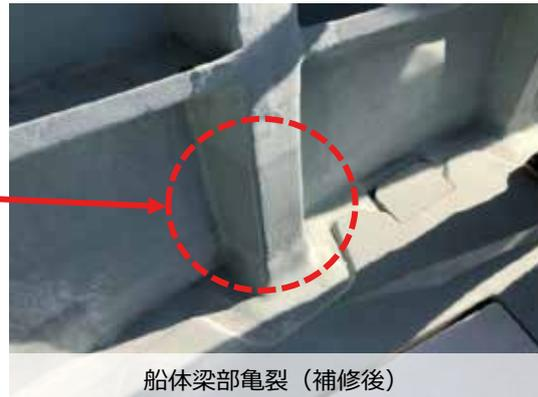
船体梁部亀裂（補修後）
