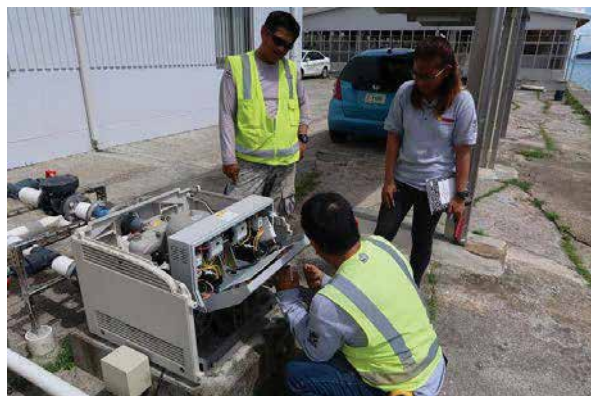
給水ポンプの不具合調査
