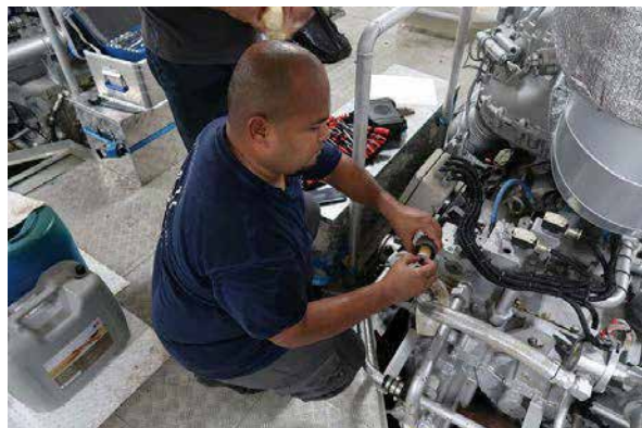
減速機のオイルフィルターの取り外し
