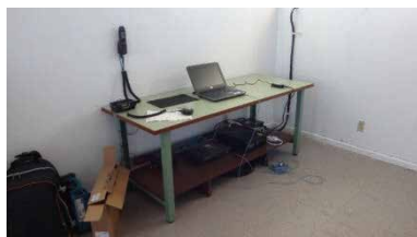
設置した無線装置
