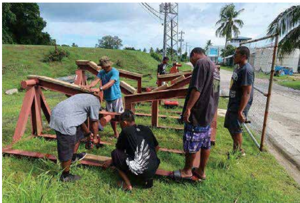
上架に先立ち架台の整備作業
