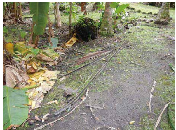
日本統治時代のレール（鉱石運搬用）
