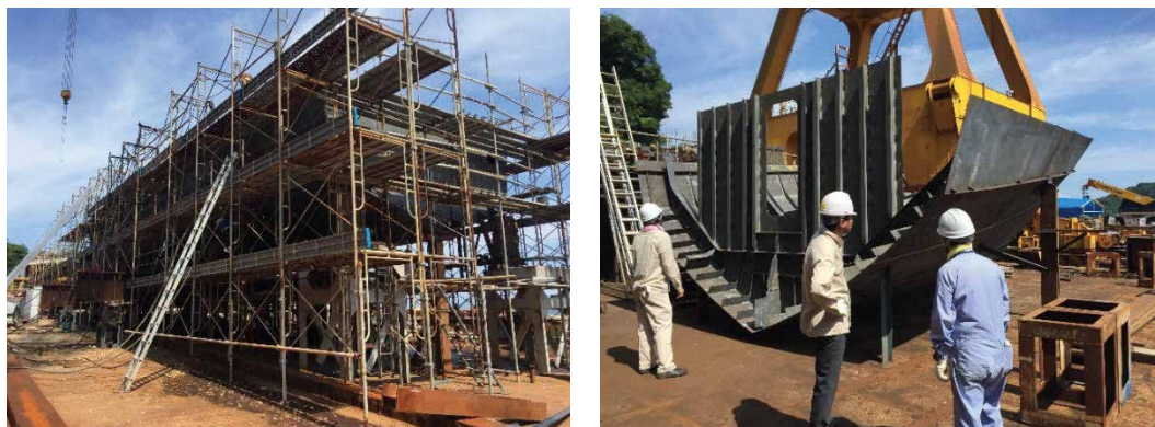
建造中の巡視船
