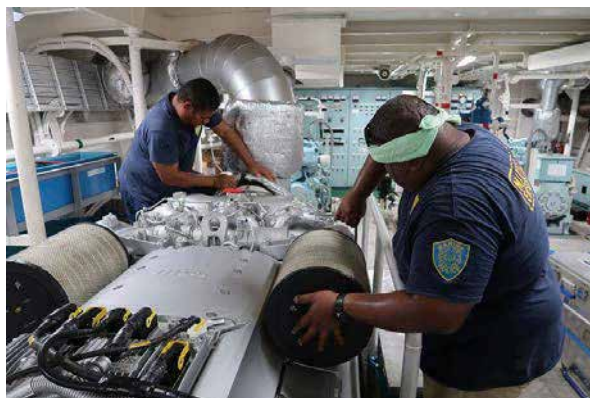
エアフィルターおよび断熱材の取り外し
