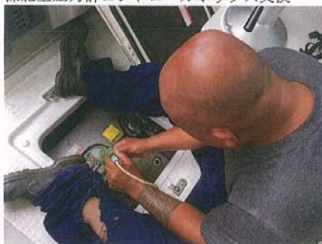
操舵室圧力計コントロールボックス交換
