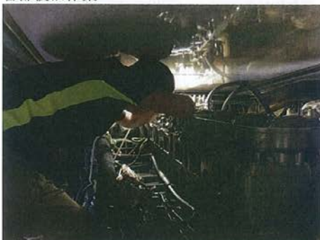
各部復旧作業
