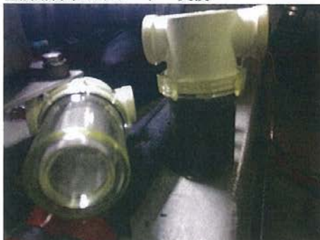
空調用海水ストレーナー交換
