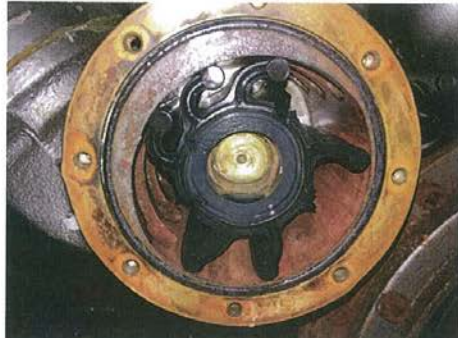
主機海水ポンプインペラ点検
