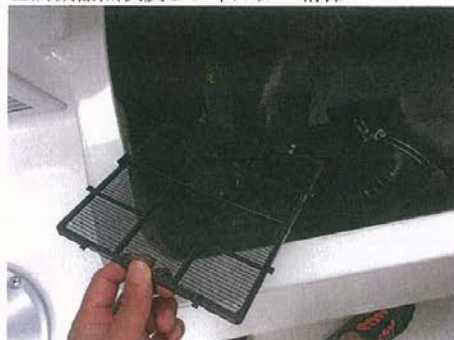
空調機器点検及びフィルター清掃
