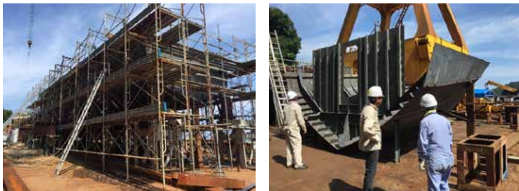
建造中の巡視船
