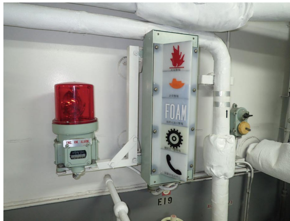
写真 3-2-6 故障等に対する机上シミュレーションが重要
