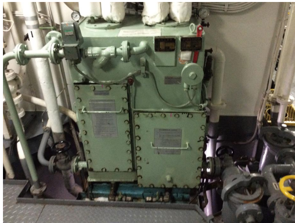
写真 3-2-18 ビルジセパレーター（油水分離器）
