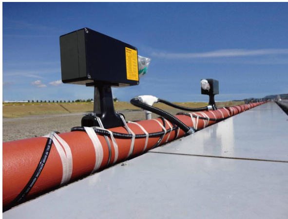
写真 3-1-28 自己制御型ヒーティング・ケーブル (株式会社テクノカシワ 提供)
