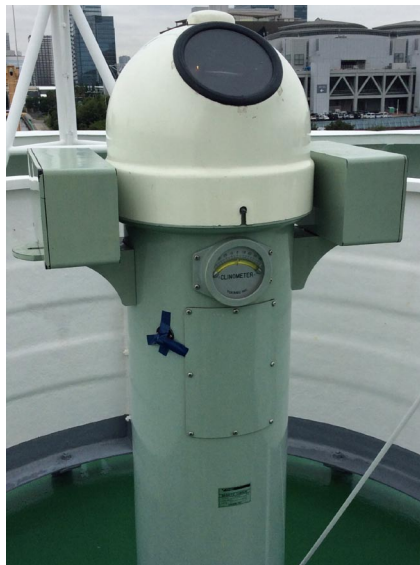
写真 3-1-3 フライング・ブリッジ・デッキに設置されたマグネットコンパス
