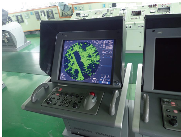
写真 3-1-8 各レーダーのスイッチ類の調整は習熟者が実施
