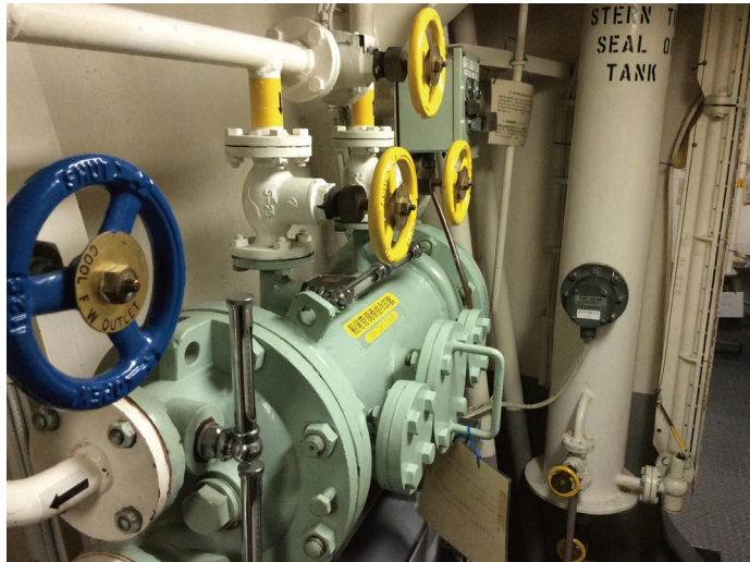
写真 1-1-1 プロペラ軸のシールタンク
