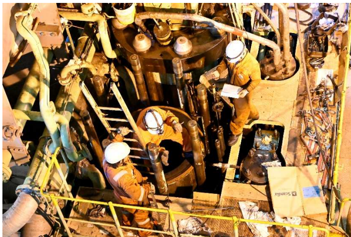
機関室 ピストン抜き
