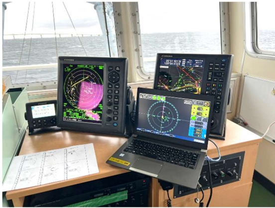
写真-2. システム設置状況
