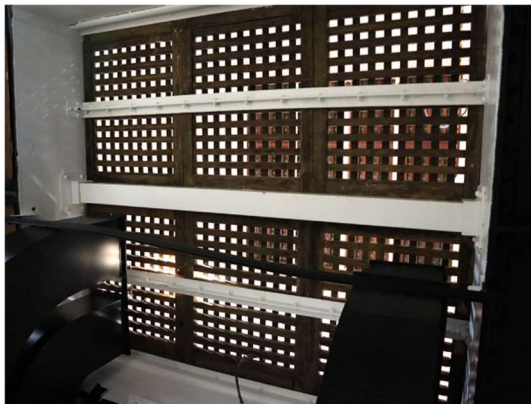
＜グレーチング・・・下から見たところ＞ 荷物を搬入する際は取り外すことができる。
