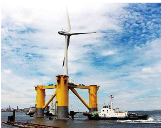
図 16 福島沖の浮体タービン
