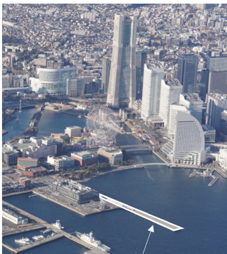
新港9号岸壁 令和5年1月撮影
