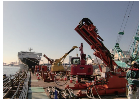
岸壁を供用しながらの耐震化工事 (品川内貿ユニットロード埠頭)
