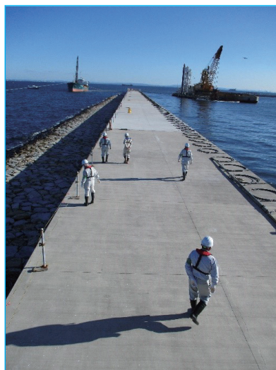
工事現場確認の状況
