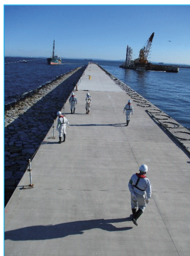
工事現場確認の状況
