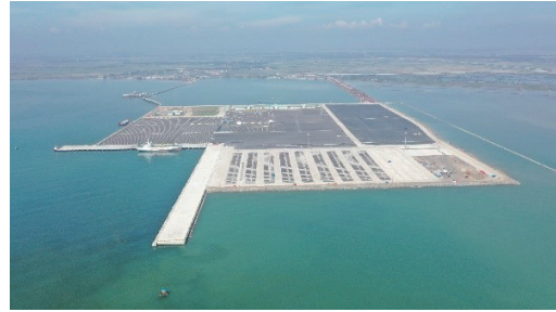
日本の軟弱地盤改良や急速施工技術を活用して埋め立てた港
