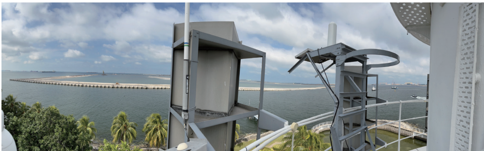
Sultan Shoal 灯台から見えるトゥアス新港造成の様子
