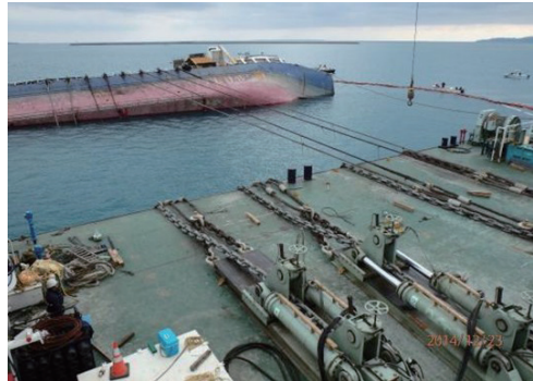
2014年沖縄中城湾で横転沈没した作業船H丸を300トン牽引装置で撤去中
