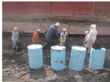
深浦町による重油の回収作業(2) H25.3.5
