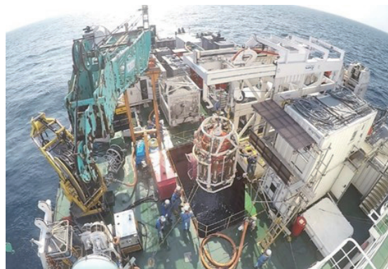
2019年同船に積載されていた重油を定点位置保持機能付き作業台船に装備した飽和潜水装置で回収中
