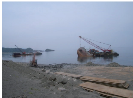
海上撤去作業状況 H27.6.26
