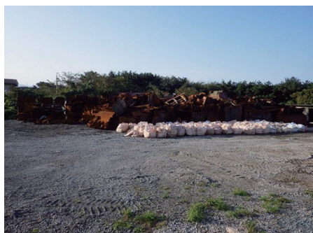
撤去した残骸の保管状況 H27.9.28
