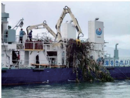
クレーンによる漂流物の回収状況
