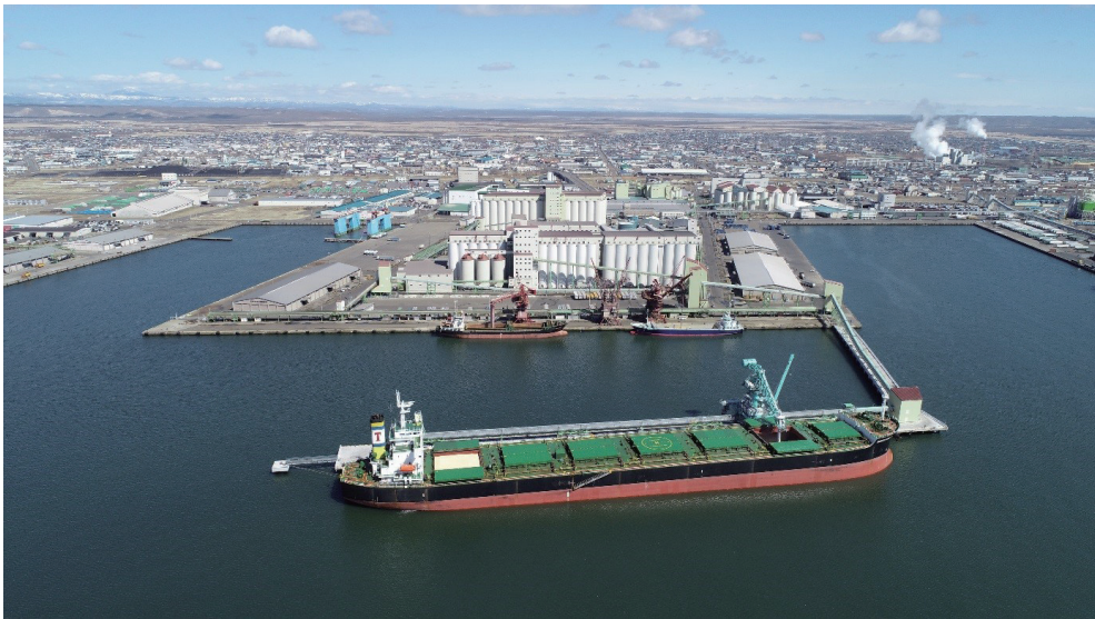
新設された国際物流ターミナルに第一船として着岸したバルクキャリア（ばら積み貨物船） （釧路西港開発埠頭株式会社提供）
