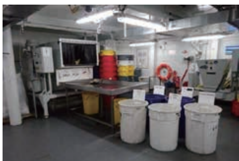
「Ovation of the Seas 号」の ごみ収集設備・焼却炉
