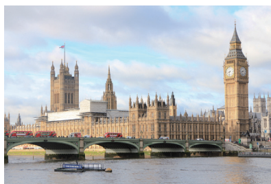
ビッグベン改修工事中（写真：左）
