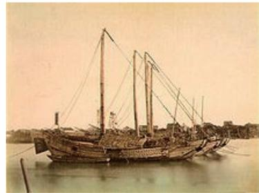
弁財船は西洋の船のように竜骨（キール）や肋骨（フレーム）を持たない平底の船で一本マスト。前と後ろには水密の部屋を持つが荷物はオープンデッキの一層で荷物の積み下ろしには便利だが波の打ち込みに弱い。太平洋や日本海で時化に会うと結合部がゆるみ浸水の原因となる。また舵は水深の浅い河口で引き上げられるように吊り下げ式で舵効きをよくするために船体に比べると面積が大きいのが特徴である。このため強い追い波に会うと破損しやすい。外洋向きでなかったため江戸時代には 200 隻以上の船が漂流したという。ここに数々の漂流物語が生まれることになる。歴代将軍は庶民の命、船の安全にはあまり関心がなかったようである。というよりも商人が先読みをして航洋船と疑われるようなガレオン船を敢えて作らなかったという説もある。
