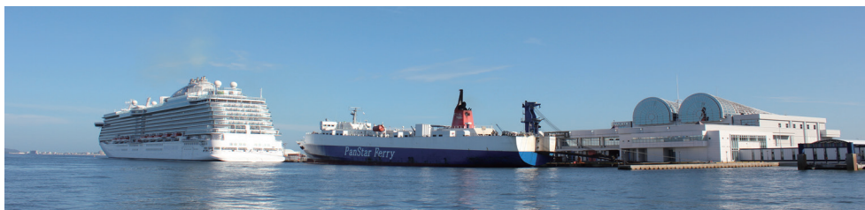
中央ふ頭の全景（右の建物が博多港国際ターミナル）
