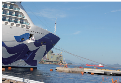
中央ふ頭の先に完成した係船柱
