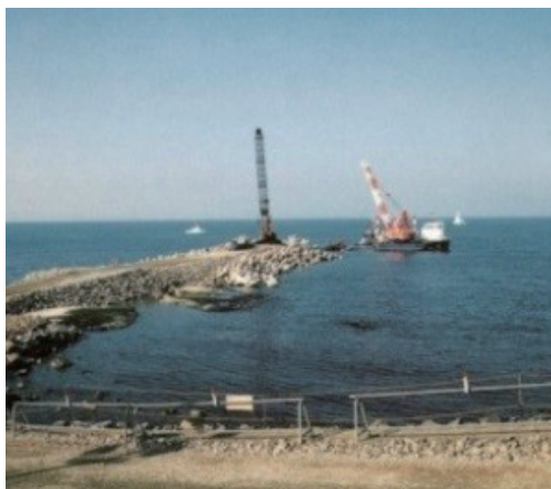
仮設道路先端に設置されたクローラークレーン
