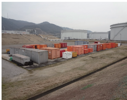
資機材の保管状況（国内第2号日本海基地）
