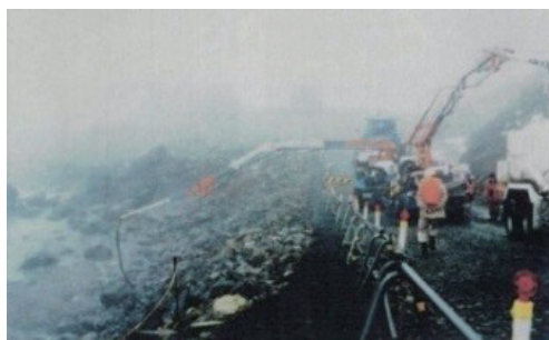
コンクリートポンプ車と強力吸引車の組合せによる漂着油の回収作業
