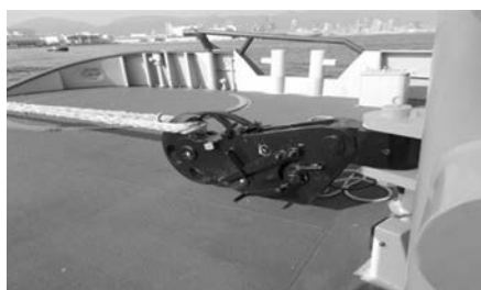
曳航フックにタグラインを掛けて曳引力計測中
