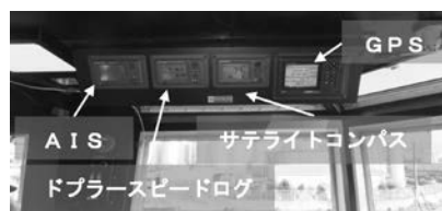
船橋左舷天井部のGPSなどのモニター
