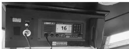
船橋天井部の無線機
