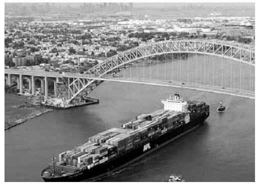
写真-2 海面上昇も考慮して桁高を引き揚げるニューヨークのベイヨン橋 出所：Port Authority of New York New Jersey
