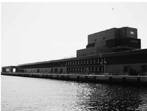
小名浜港1号ふ頭に整備中の魚市場
