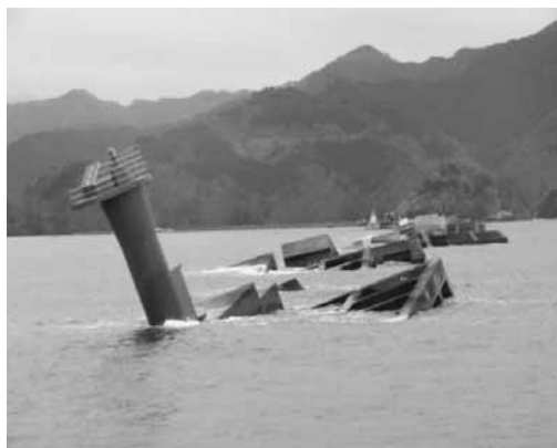
図1 倒壊した湾口防波堤（釜石港）
