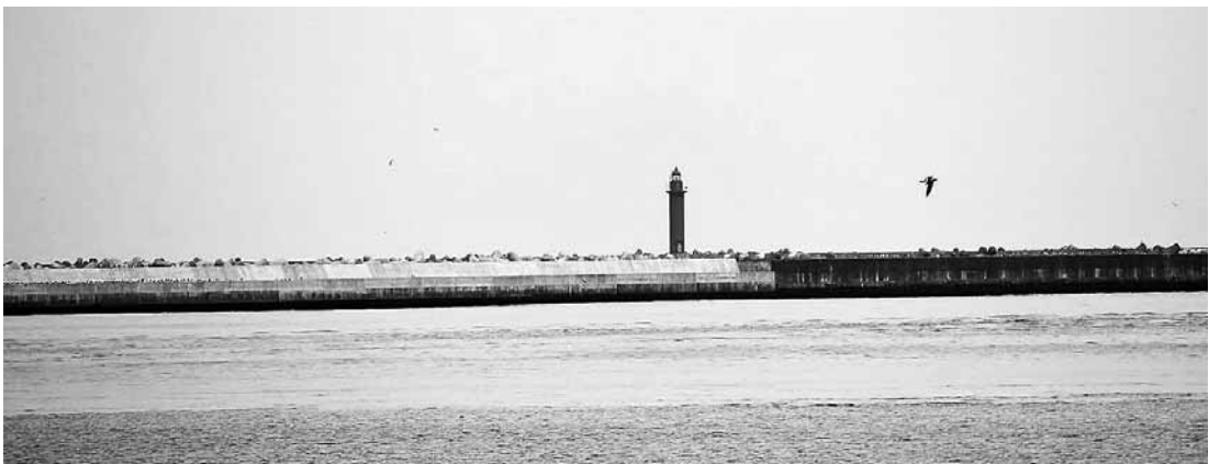
ケーソン設置が完了した八太郎北防波堤
