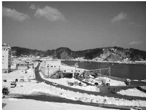
宮古港の防潮堤整備箇所 (岩手県県土整備部：平成26年2月18日撮影)
