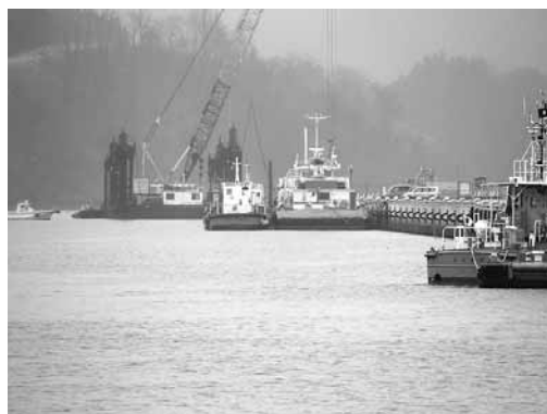
市場手前の岸壁では復旧工事が継続されている
