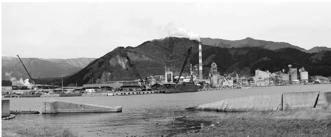
大船渡港の復旧した岸壁と復旧前の護岸
