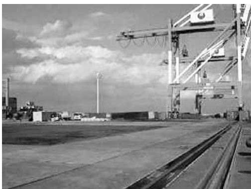
写真-1 茨城港の常陸那珂港区北埠頭（上：被災、下：復旧、4月1日供用開始） 出所：国土交通省関東地方整備局「茨城県内港湾の復旧状況」H23年5月16日
