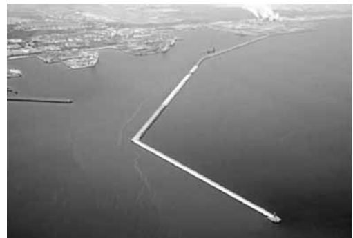
図4 復旧事業が完了した北防波堤(八戸港)
