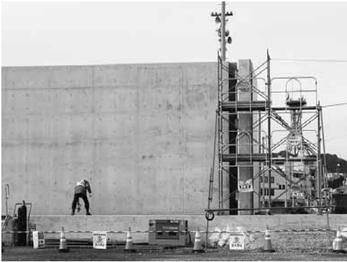
設置工事中の防潮堤（大船渡）
