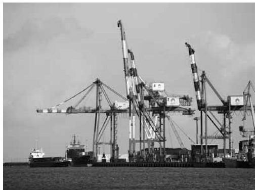
復旧したガントリークレーン
