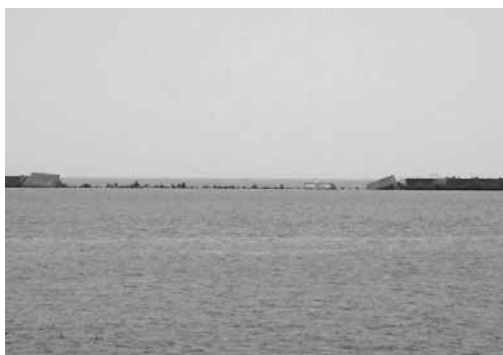
倒壊した八太郎北防波堤
