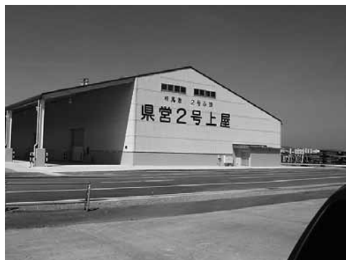
復旧後の2号上屋（福島県提供）
