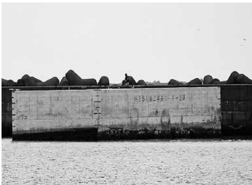
震災後に据え置かれたケーソン
