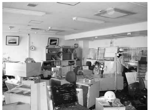
フェリーターミナル1階の事務所
