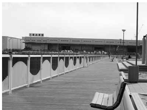
中央公園前護岸（復旧後）
