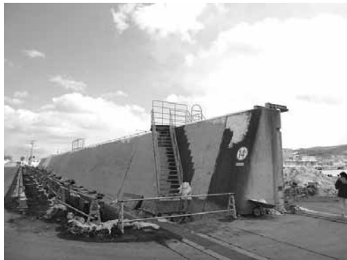
久慈港の防潮堤基礎部分 (岩手県県土整備部：平成26年2月21日撮影)
