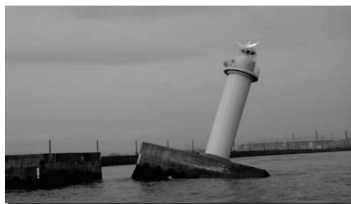
東日本大震災における大地震 および大津波により傾斜した灯台
