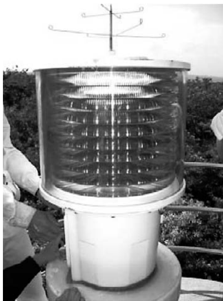
LEDを光源とした航路標識
