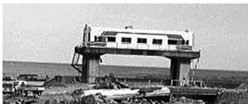
岩手県の明戸川水門の被害状況、水門制御室は三陸鉄道と同じデザイン、三陸鉄道の電車と同じ塗装をしている。
