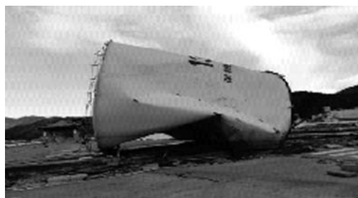
気仙沼港の壊れた石油タンクと油漏れ
