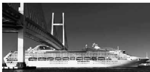
横浜ベイブリッジを通過するサン・プリンセス（77,441総トン） マスト高50m、横浜ベイブリッジの桁下高55m
