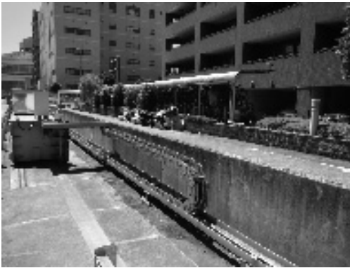
写真4：日の出埠頭周辺の高潮防潮堤と水門
