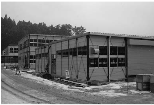
他校のグラウンドに建てられた仮設校舎
