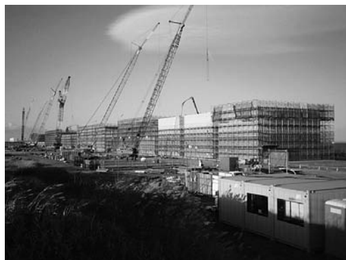
相馬港沖防波堤ケーソン製作の様子
