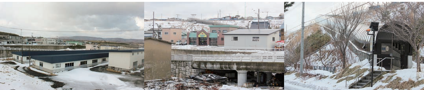
左から漁師たちの共同作業場、6mかさ上げされた新しい街並みの向こうには高台への避難路がみえる。高台に続く屋根付き避難路の入り口。この地点の海拔は8.6mと記されている。
