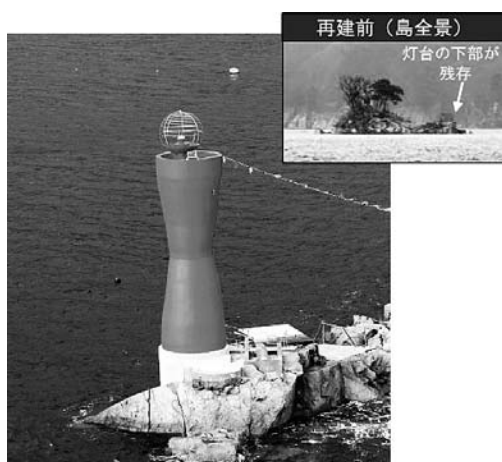
写真3 再建した大槌港灯台（岩手県大槌町）
