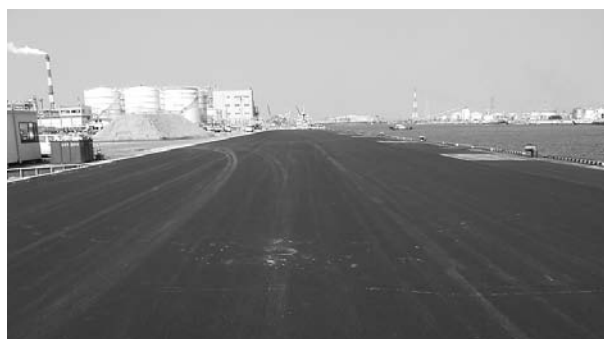
鹿島港 A 岸壁復興状況
