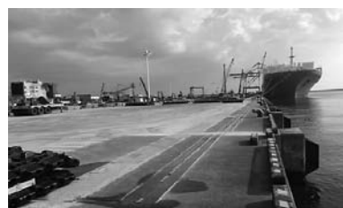
常陸那珂港区 B 岸壁復旧状況
