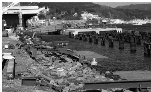
修復工事中の、市場南側岸壁
