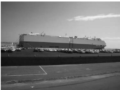
日立港区 B 岸壁復旧状況
