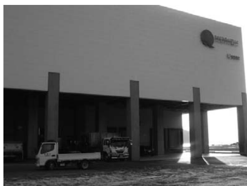
大型冷凍冷蔵施設・マスカー(女川)
