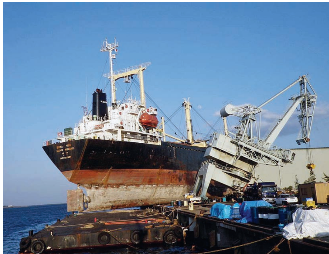
仙台塩釜港（仙台区）の荷役施設をなぎ倒し、岸壁に乗り揚げた大型貨物船
