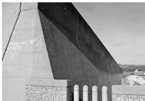
高さ11.7mにおよぶ巨大な防潮堤
