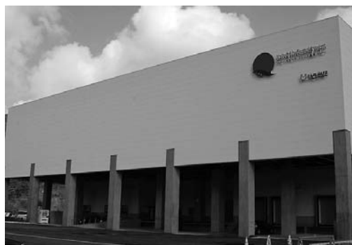
大型冷凍冷蔵施設は MASKAR と名付けられ、女川の復興のシンボルとして港で目立つ。
