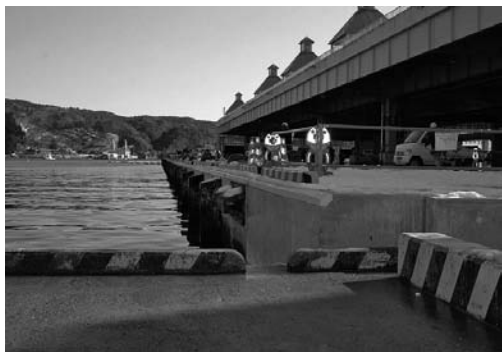
一部かさ上げ工事を終えて使用している市場前岸壁。手前の岸壁との段差が分かる
