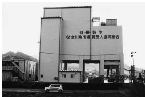
女川漁港で新設された製氷工場 (2013.1.24撮影)
