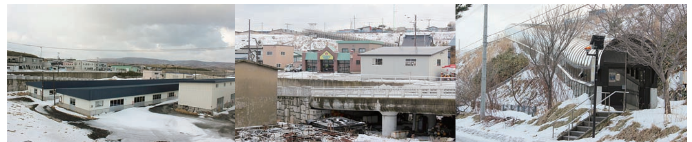
左から漁師たちの共同作業場、6mかさ上げされた新しい街並みの向こうには高台への避難路がみえる。高台に続く屋根付き避難路の入り口。この地点の海拔は8.6mと記されている。
