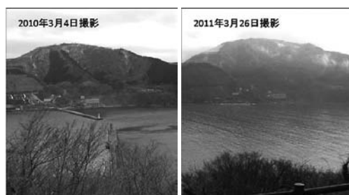
写真1：女川港防波堤の被災状況
