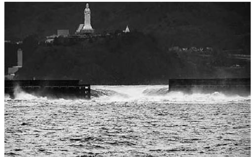
引き波により破壊された防波堤の状況
