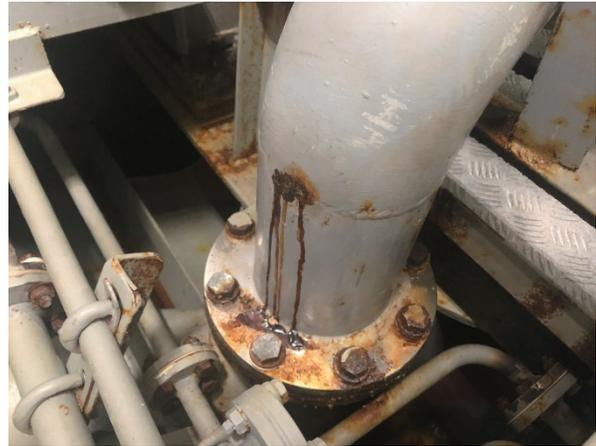
錆による海水配管のピンホールを確認
