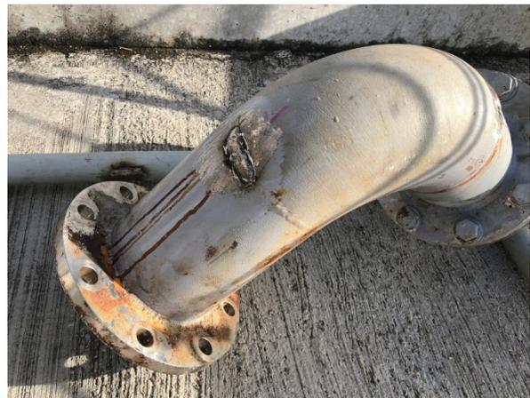
海水配管のピンホールを溶接
