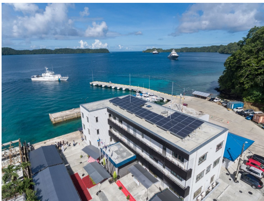
供与された 40m型巡視船、係留施設、庁舎
