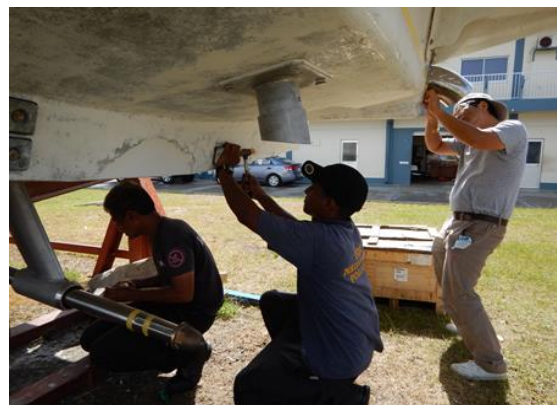
オイルの注入
