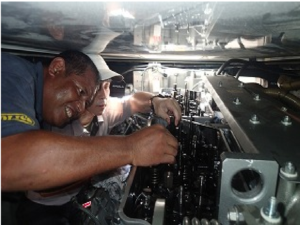
狭い機関室内での機関整備実習状況
