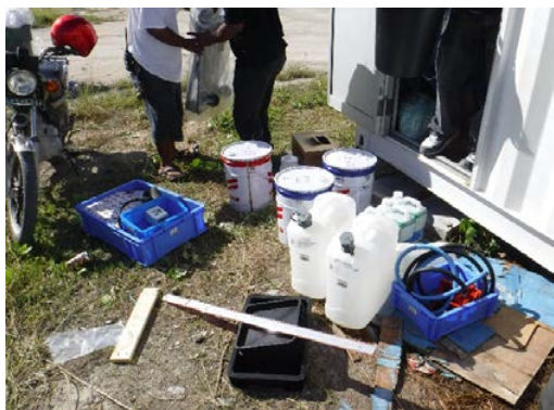
防蝕亜鉛の取外し
