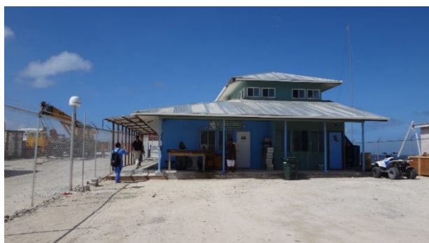
陸上の通信設備を設置した港湾事務所
