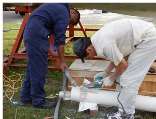
アンテナブラケットの修理
