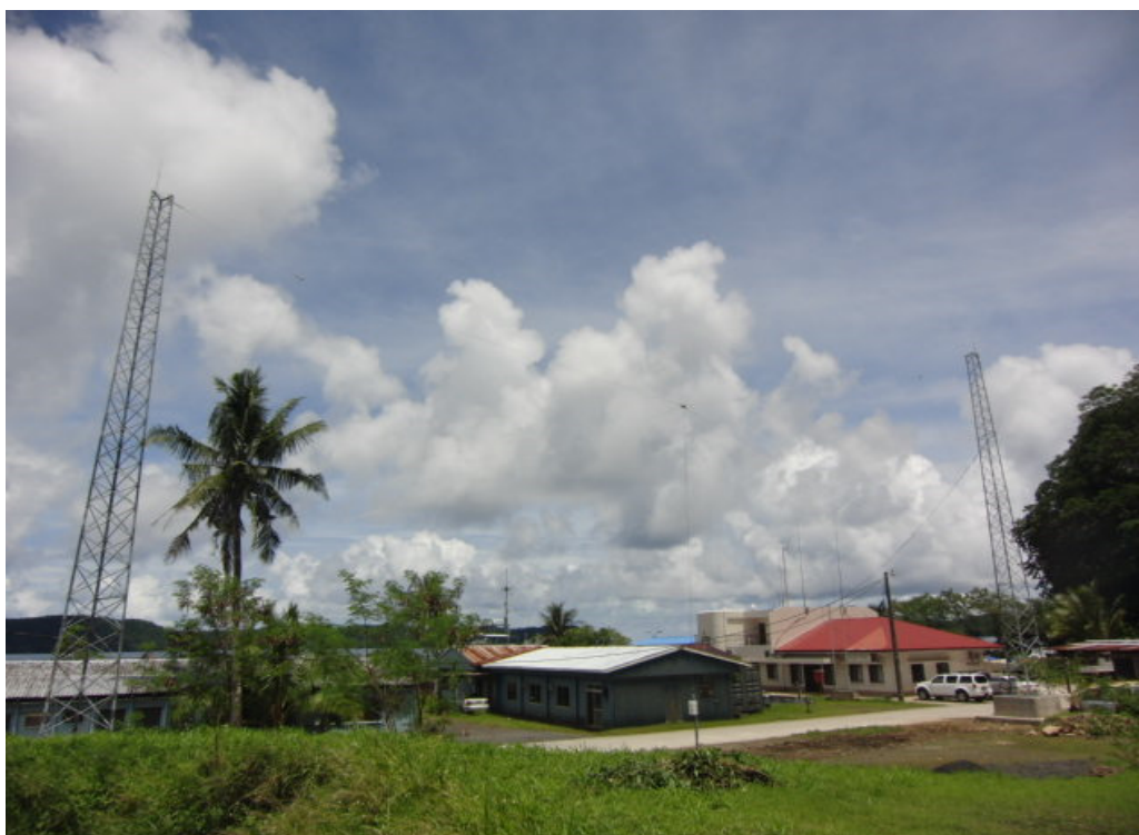
パラオ共和国へ供与したHF通信用アンテナ
