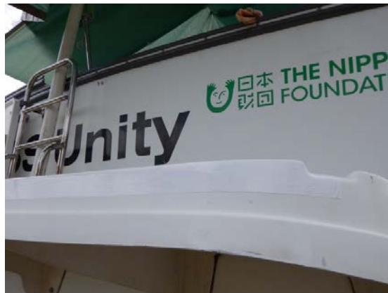
FRP補修後のトランザムステップ
