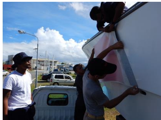
アンテナ及びアンテナブラケットの取付け
