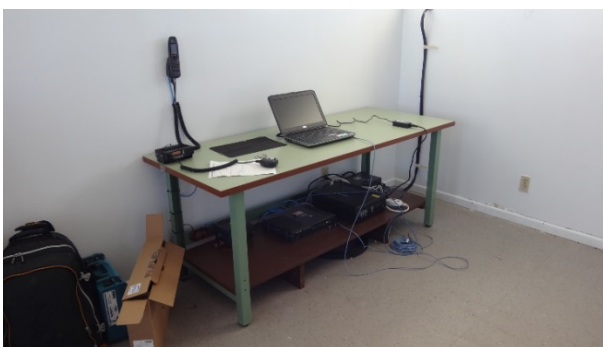
設置した無線装置
