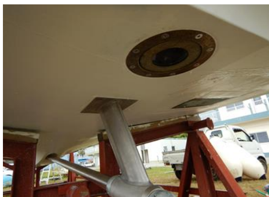
FRP修理及び補強後のシャフトブラケット 取付け部の内側
