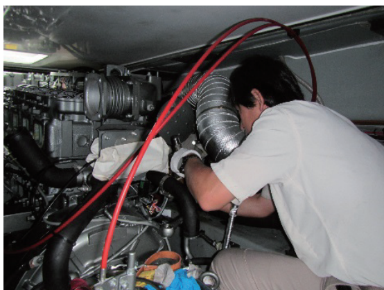
燃料噴射弁の交換
