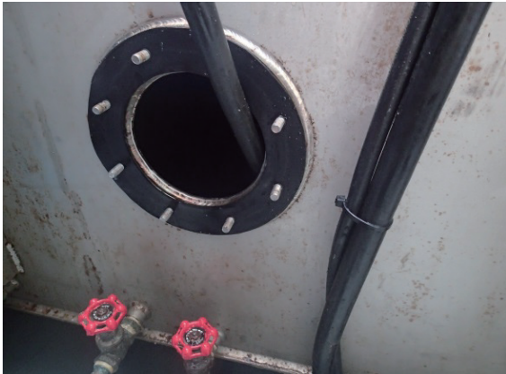
過給機吸入フィルターの清掃
