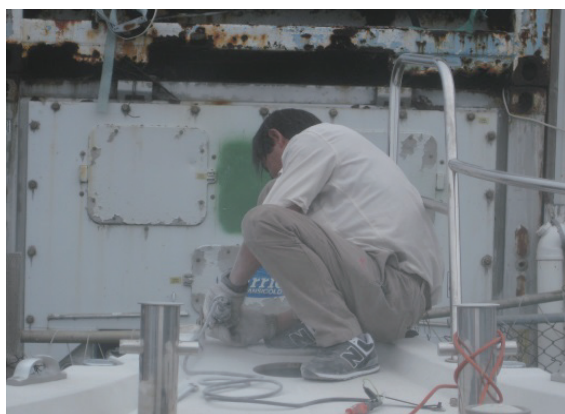
手摺取り付け部分のFRPの補修
