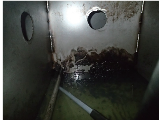
過給機吸入フィルター組み付け後
