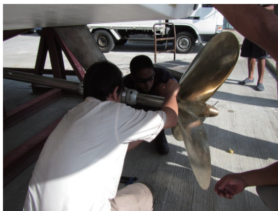
日本財団ロゴ補修前（一部剥離）
