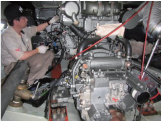
取り外したインタークーラーと海水フィルター
