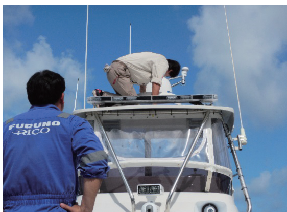
ポリス用回転灯の点灯確認・配線調整
