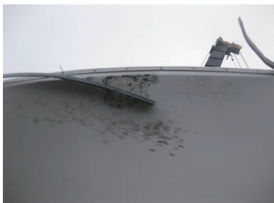
台風の際に破損したフェンダー
