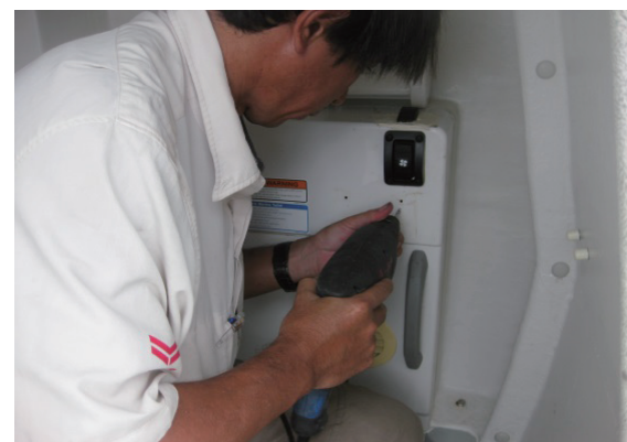
壊れたマリントイレ ペーパーホルダーの交換
