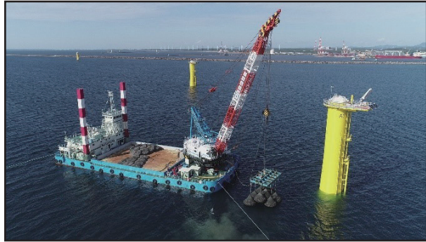
FU 設置状況
