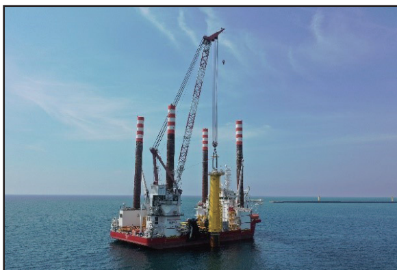
TP 据付状況
