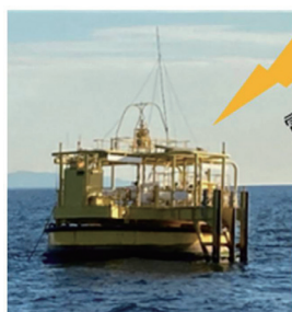
AIS信号所が設置されているシーバースの例
