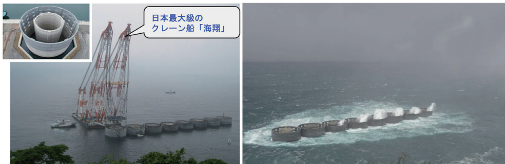
図 5 現地における二重円筒ケーソン式防波堤
