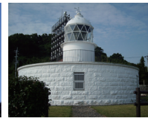
へさき 部埼灯台 (福岡県北九州市)
