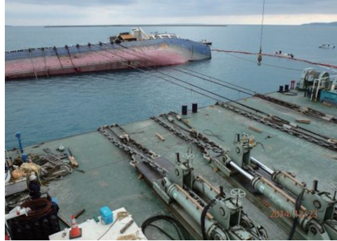
2014年沖縄中城湾で横転沈没した作業船H丸を300トン牽引装置で撤去中
