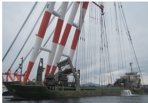
2016年大分佐伯湾で船体重量3000トンの作業船G号を3700トン吊起重機船で吊り上げ撤去中
