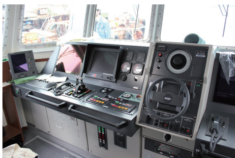
船橋に設置された操船機器
