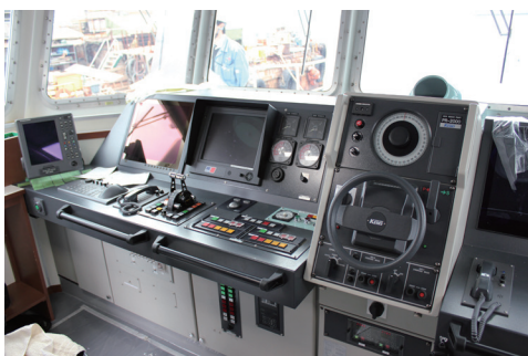
船橋に設置された操船機器
