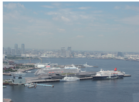
大さん橋全景（横浜マリニタワーから）
